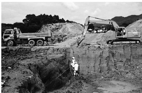
Fig. 20 池底の重機掘削
