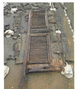
1982 山田寺で倒壊回廊発見
