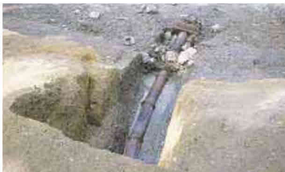
横浜居留地下水道用の陶管を用いた暗渠（西南から）
