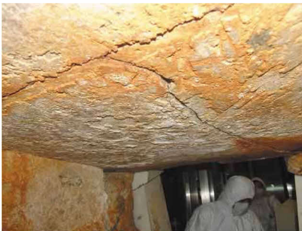
高松塚石室の石材の劣化
