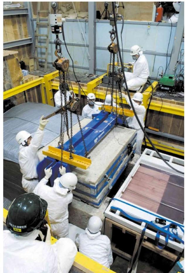
天井石3の取り上げには、ⅡⅡ型治具が使用され、バランス調整のため、5基のチェーンブロックを操作して地切りをおこないました。
