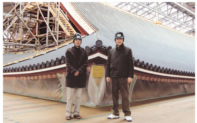
平城宮第一次大極殿復原現場にて（右が兪 洪植先生）
