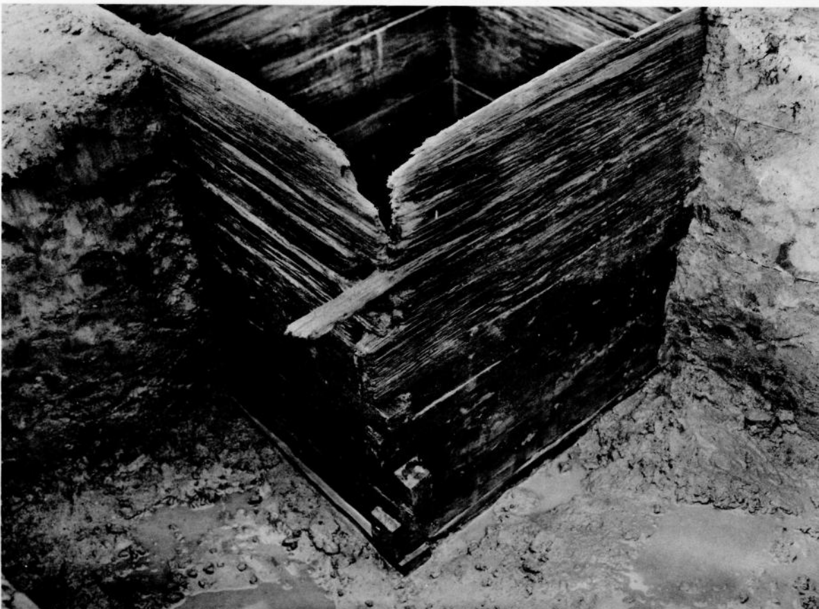
3. 同上 東南隅井戸枠組方の状況
