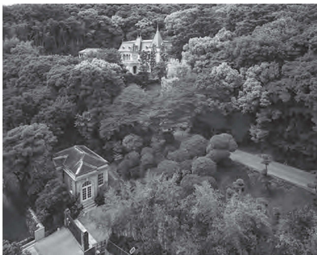
図45 敷地全景（南東から）
