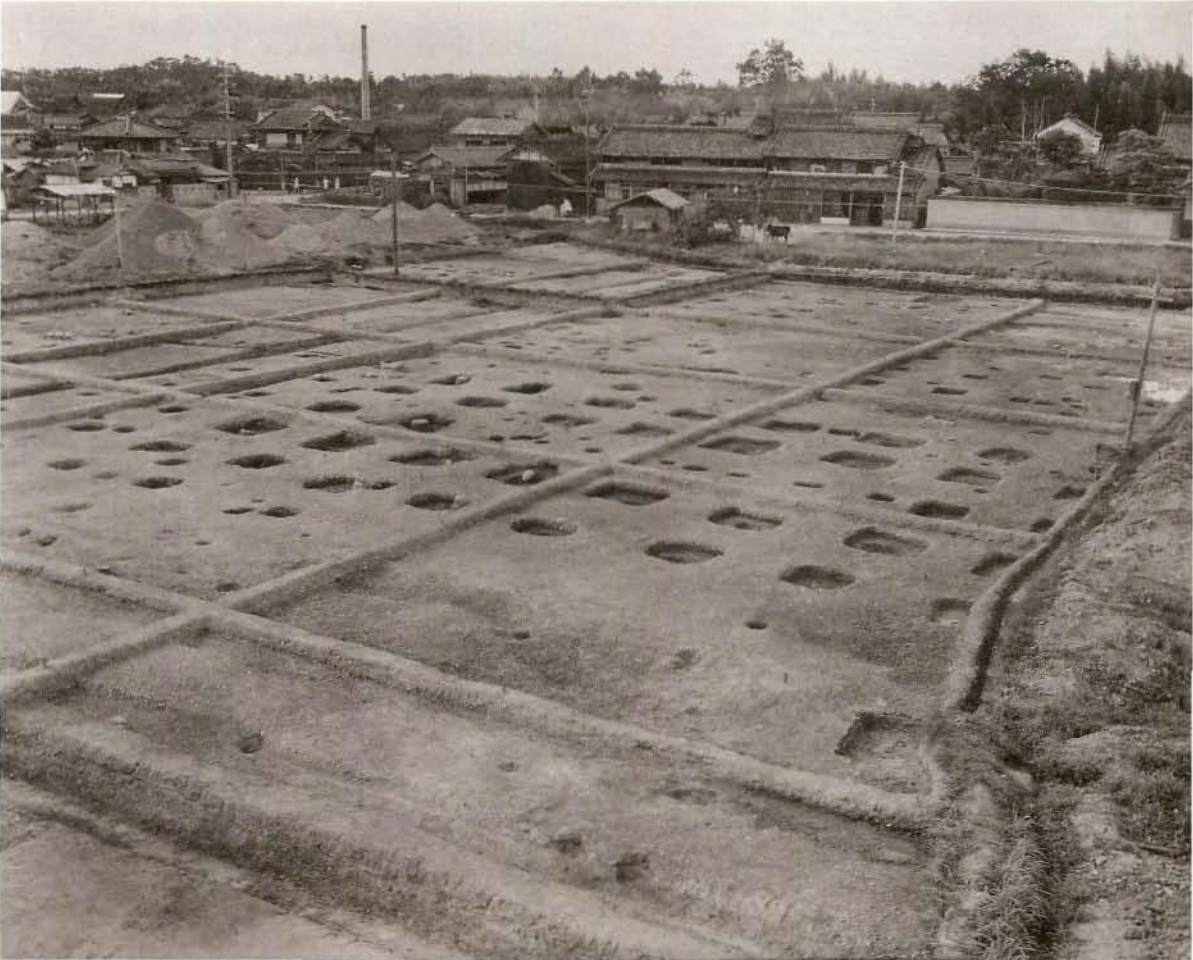
3. 同 上 東南から
