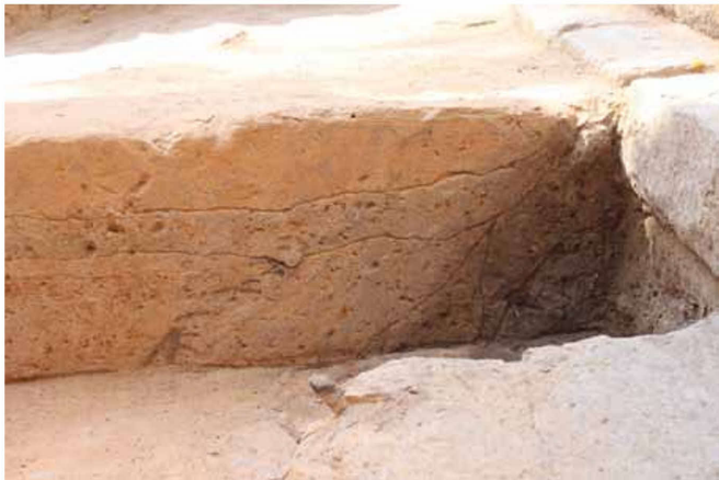
南祠堂の下成基壇の断面の様子。基壇の内部はサラサラの砂によって充填されていた。 Profile of the inside of the lower foundation of the Southern Sanctuary. The interior of the foundation is filled by loose sand.
