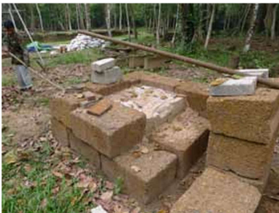
南祠堂の基壇・掘込地業に充填するための土壌の強度試験用のテスト・ユニット Test-unit for strength of consolidated soil for the platform and foundation of the Southern Sanctuary
