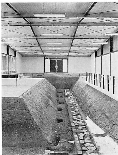
第6図 遺跡覆屋内部
