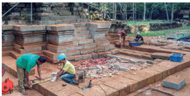
南祠堂再構築状況
