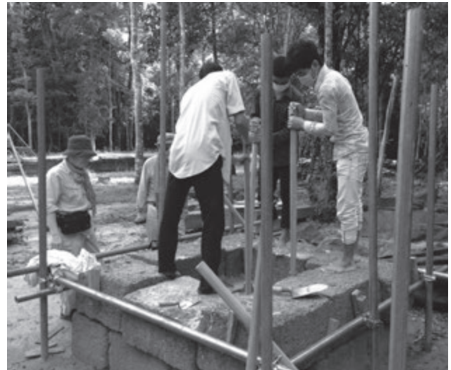
第2図 基壇土試験盛土
