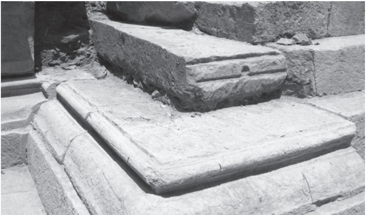
第 43 図 中央祠堂南階段 西袖部内側の転用石材
