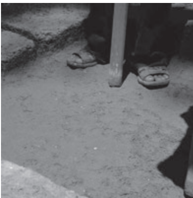
写真-16 丸い突き棒による均しと締め固め
