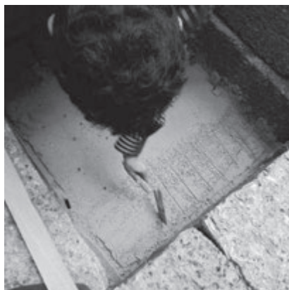
写真-20 締め固め土表面の剥離防止
