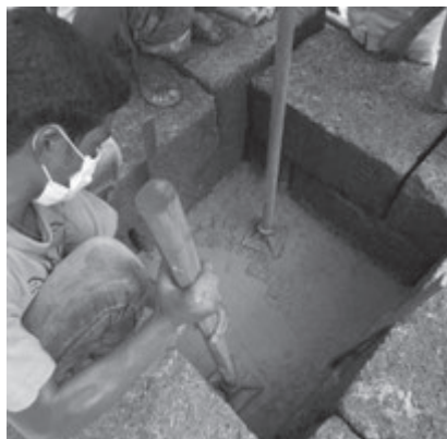
写真-17 像の足による締め固め
