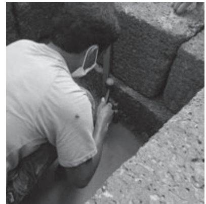
写真-18 ラテライト接触部分の締め固め
