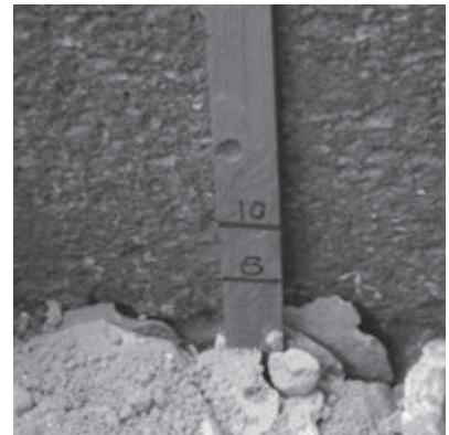
写真-15 巻きだし厚さと締め固め厚さ
