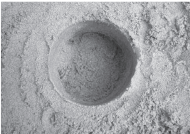
写真-8 下成基壇盛土の侵食状態
