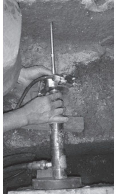
写真 -27 養生後側壁部分の強度検査
