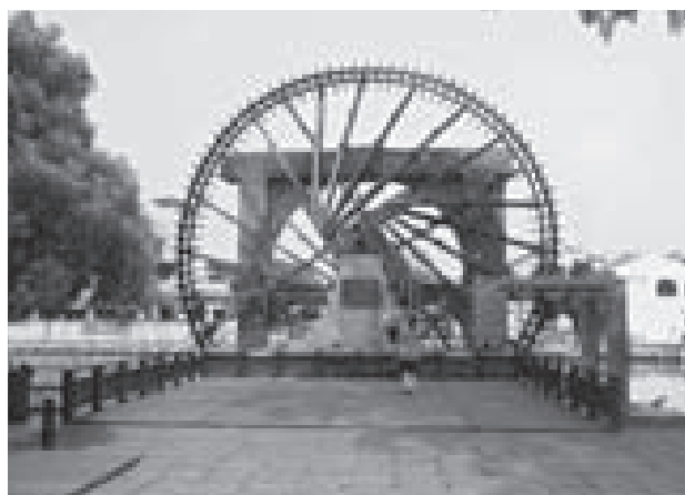
図-9. 新設された水車
