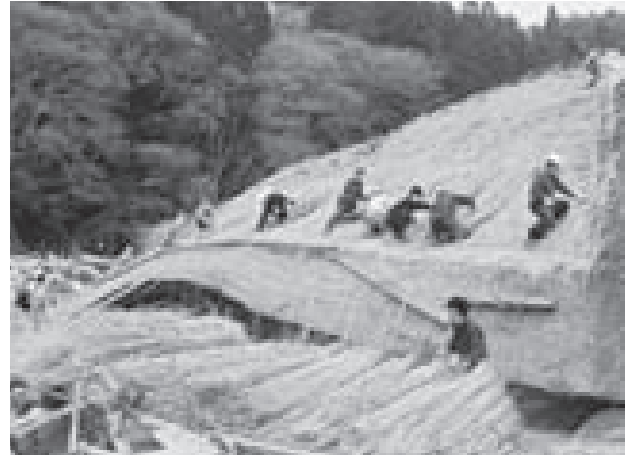
図-10. 残った茅葺き屋根を解体保存するボランティア
