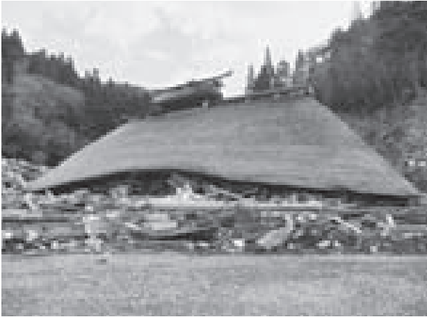
図-9. 津波で全壊した尾形家住宅（気仙沼市）
