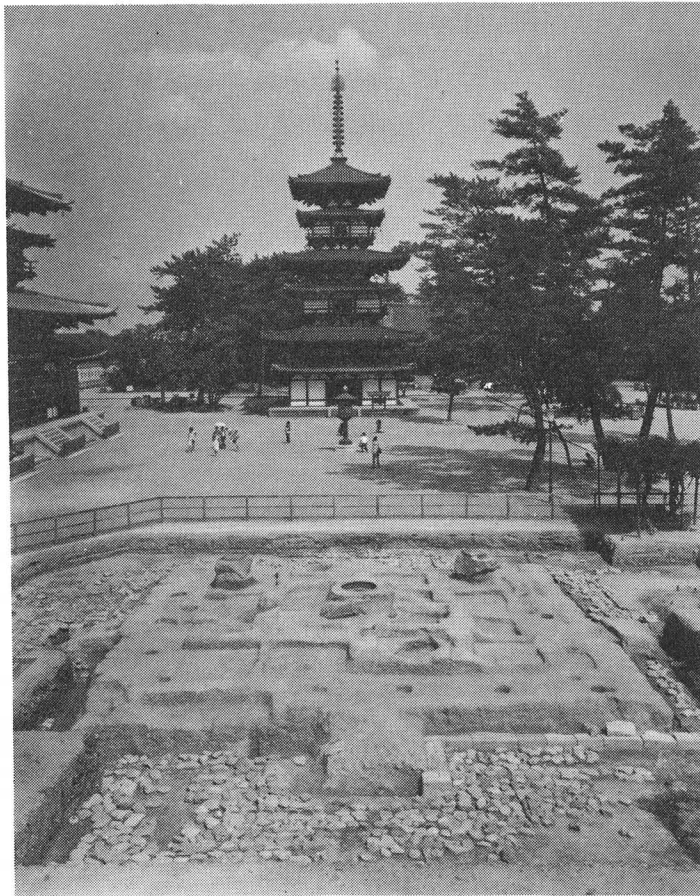
第11図 薬師寺西塔基壇（西から）
