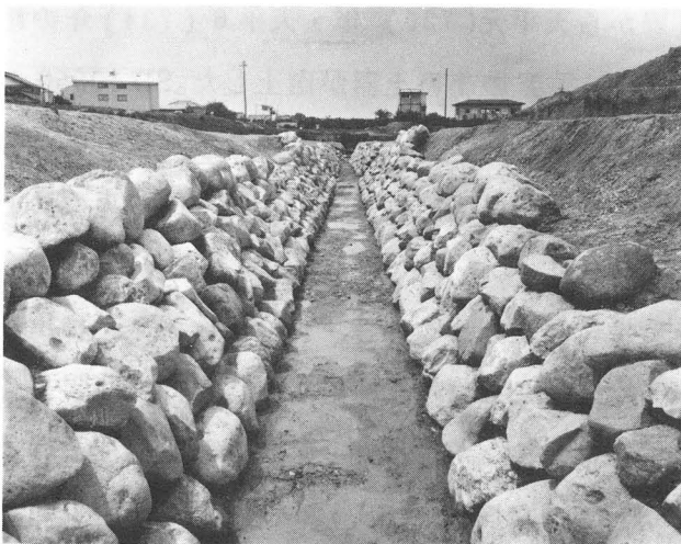
第2図 東大溝SD 2700 南から
