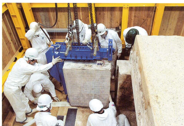
東壁石3（女子群像）は、床石と壁石の間と上部の相欠き部の隙間に先端刃を挿入して「Γ」型治具を取り付けて、地切りと移動をおこなった。
