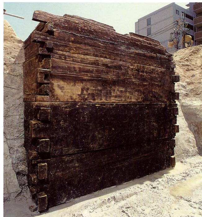
西大寺食堂院で出土した井戸枠
