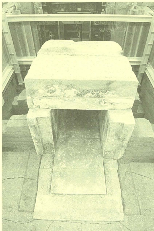
解体中の石室（北から）
