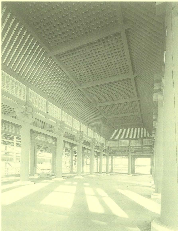
初重内部空間 基壇上より（2007年11月7日撮影）南西から
