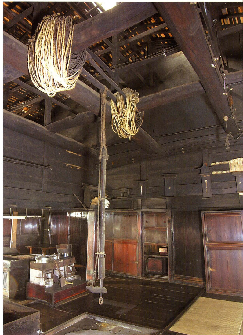
建造物研究室 重要文化財堀内家住宅(塩尻市)の建造物調査
