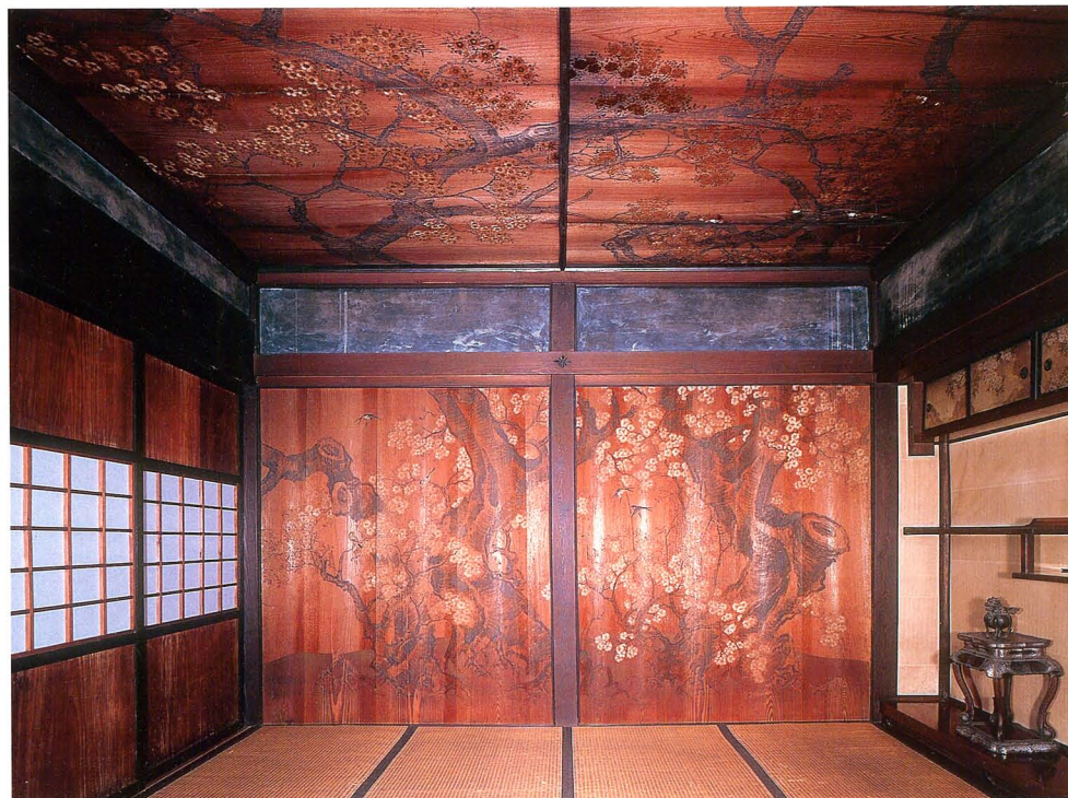
重要文化財小野家住宅（塩尻市）の建造物調査
