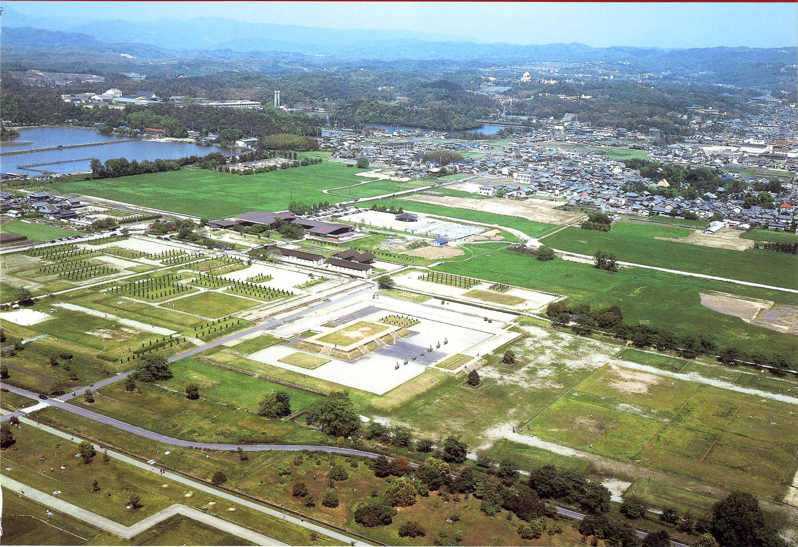
平城宮跡整備状況 (中央は第二次大極殿基壇)
