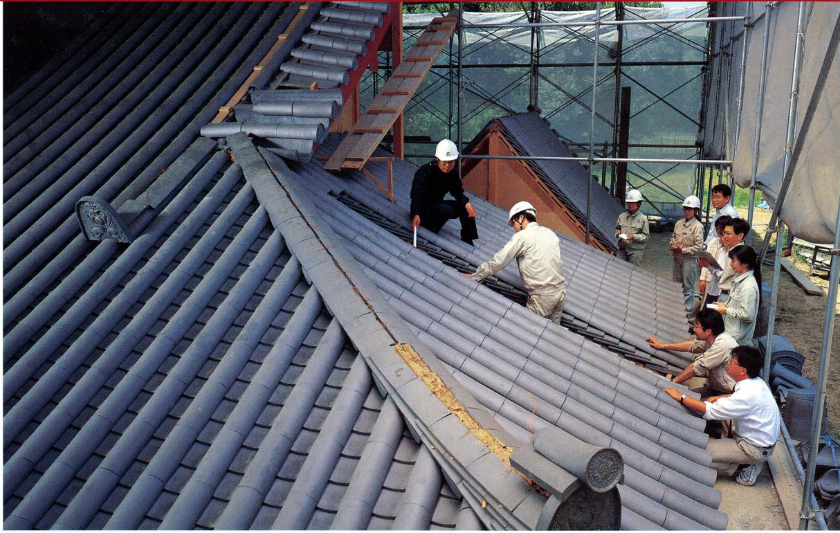
第一次大極殿復原の実物大屋根廻り 模型による検討
