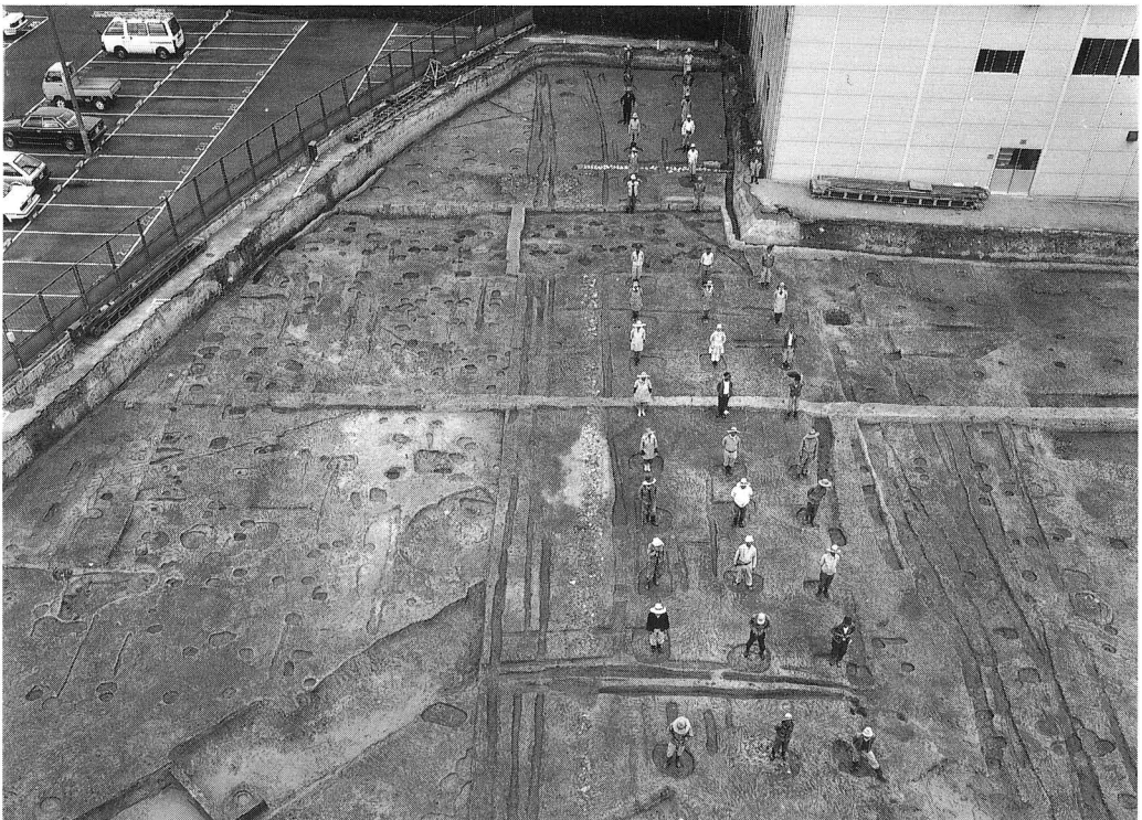
写真11 第209次 西隆寺東面回廊の遺構全景（南から）
