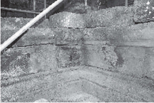
図4 中央祠堂と南塔の下成基壇接合部分
