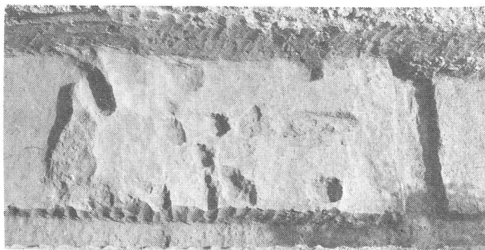
回廊基壇（下が北）
