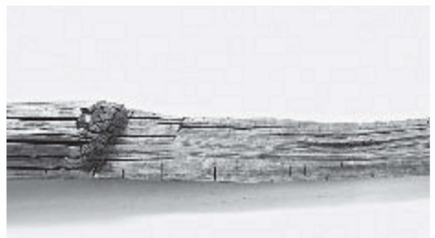
図91 材に残る斜めの欠き込み
