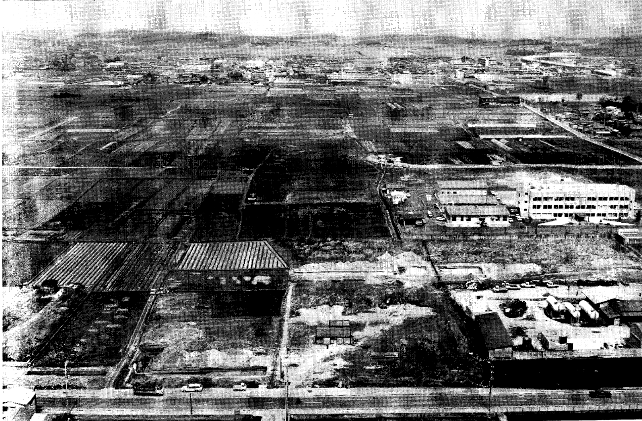
三笠中学校・左京三条二坊調査遺構(上) 朱雀大路調査状況(下)
