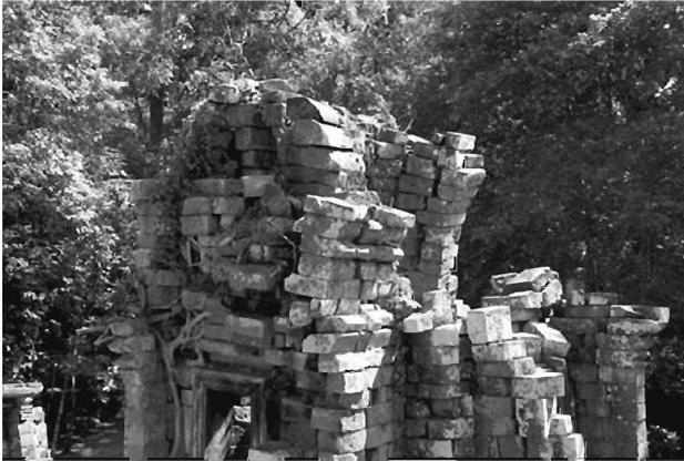
図22 中央祠堂頂部の破損状況
