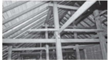
図46 浄土院政所の小屋裏
