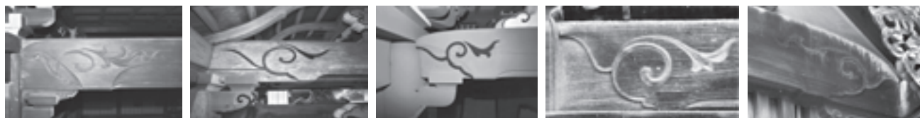
図41 虹梁絵様の比較(左から延暦寺浄土院拝殿・同唐門・同伝教大師御廟・大通寺本堂・大徳寺仏殿)
