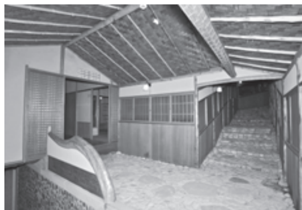
図50 井植山荘浴室棟前廊下
