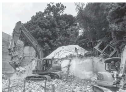
キトラ古墳墳丘整備にむけた覆屋の解体
