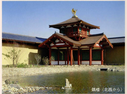
隅楼（北西から）
