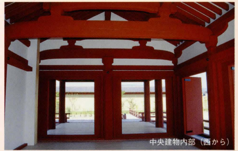
中央建物内部（西から）
