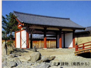
北東建物（南西から）
