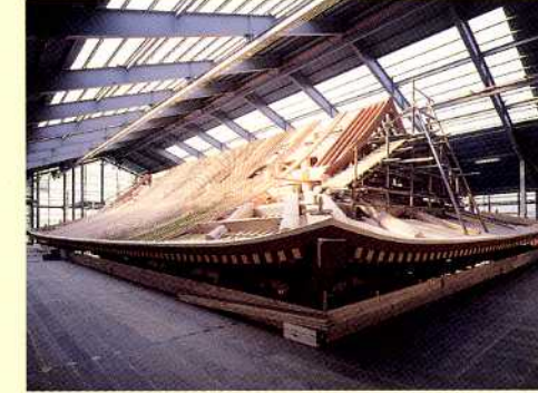
垂木をかけ、屋根をつくる
