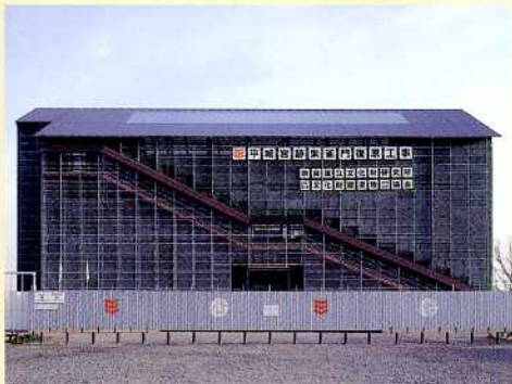
建設用覆屋（素屋根）の組立 (建設時の足場とするとともに雨風を防ぎます)
