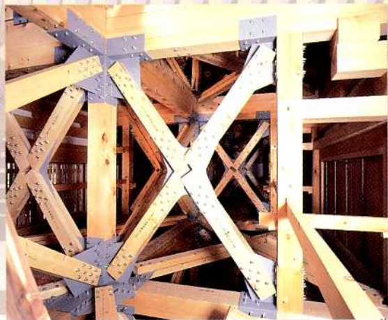
補強材の入った二重の内部
