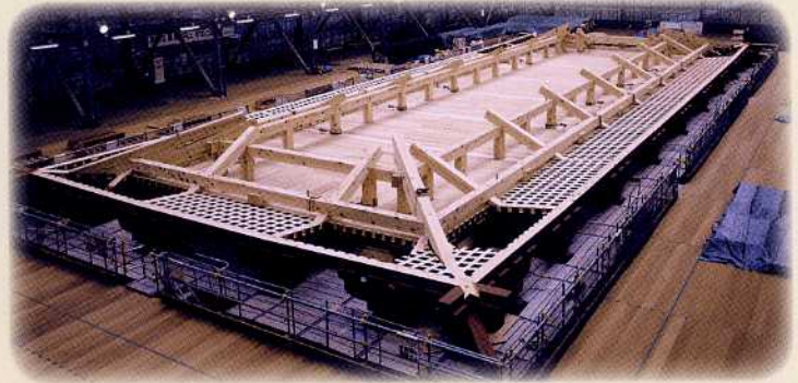
外観だけでなく、構造にも古代建築の特性を活かしています。免震装置の導入とあわせ、補強は最小限に留めることができました。
