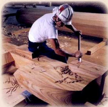
部材の加工・仕上げには古代の道具を用いました。写真のヤリガンナ仕上げに加え、柱はチョウナで加工しています。
