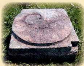
恭仁宮大極殿に残る礎石 (上：花崗岩、下：凝灰岩)
