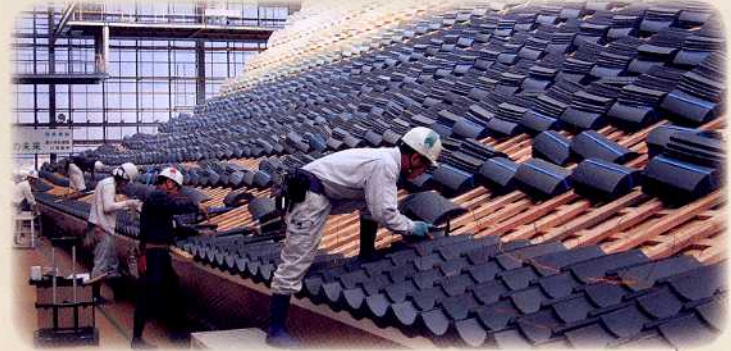
屋根荷重の軽量化をはかるため、実際の屋根瓦施工では、瓦の葺き土を用いず、各瓦を縦棧に銅線で留める「空葺き」としました。
