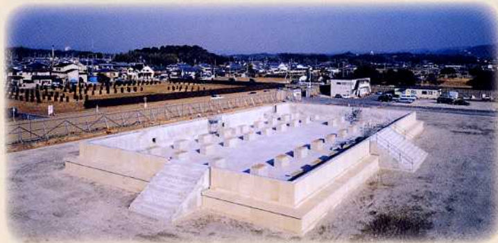
基壇は、遺構を盛土で保護した上に、杭を打たずに築かれています。基壇内部に免震装置を導入し、地震力を軽減しています。
