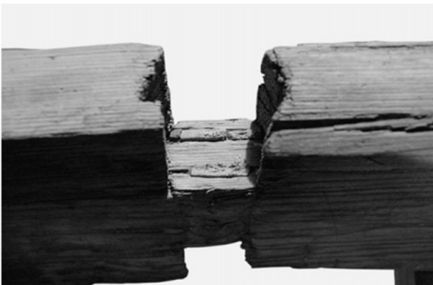
図15 相欠き仕口に打ち込まれた割り楔 (西面南壁板2段目)
