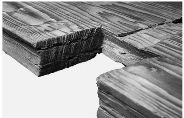
図16 土居との仕口に打ち込まれた割り楔 (東面南壁板1段目)
