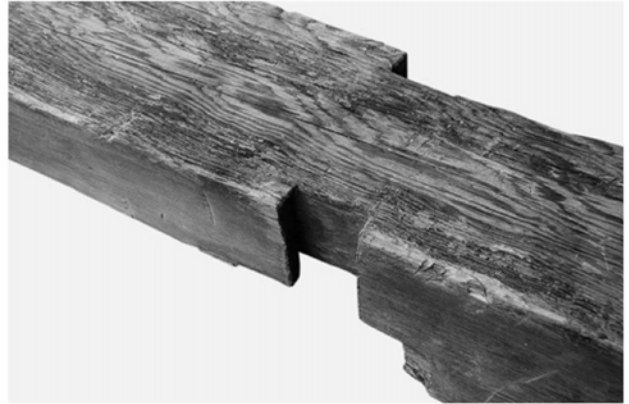
図12 土居に残る蟻掛け仕口
