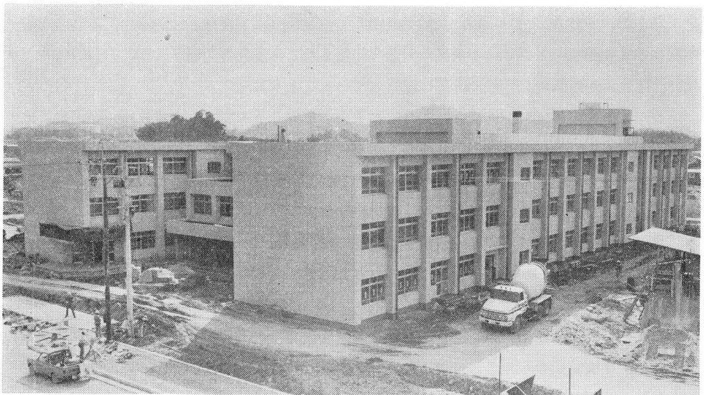
第18図 建設中の畷傍東小学校
