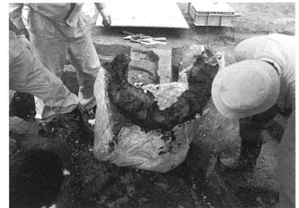
6. 発泡ウレタンが固まってから鑄型を取り上げる。
