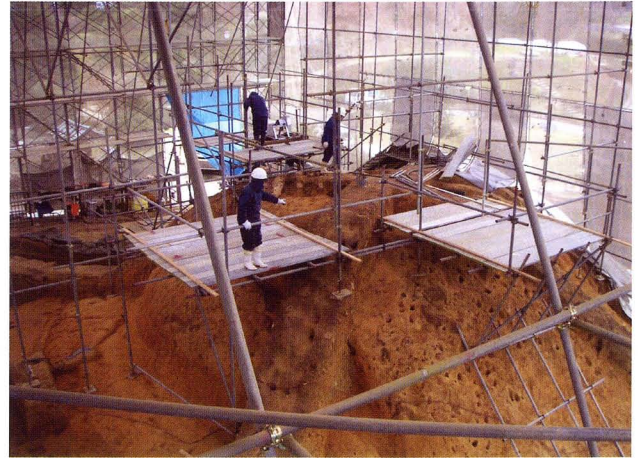
Fig. 38 試料採取に向けた足場の設置状況 (墳丘と石室への影響を避けるために古墳全体を覆う仮覆屋基礎から組み上げている)
