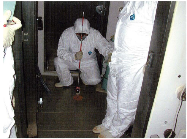
Fig.57 保存施設内の基準点移動作業
