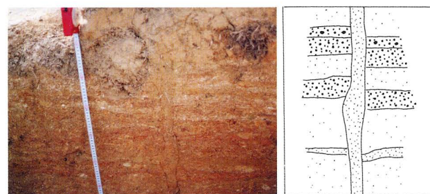
Fig. 48 トレンチ南壁における亀裂とその断面図
