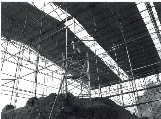
Fig.13 覆屋内の写真測量風景
