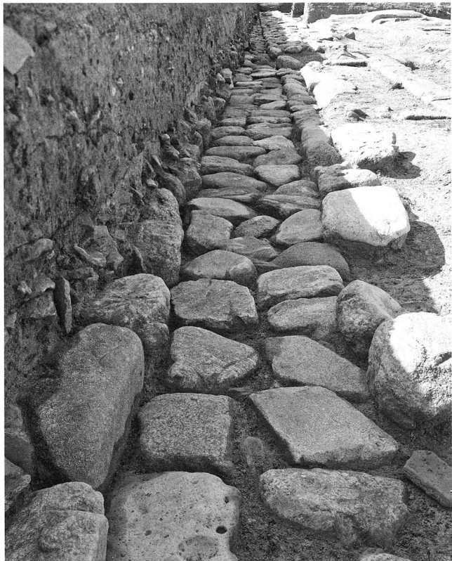
第11図 基壇南面雨落溝SD3048（東から）
