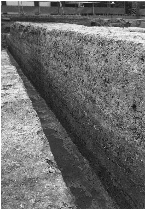
第6図 食堂基壇西半の版築層(南東から)
