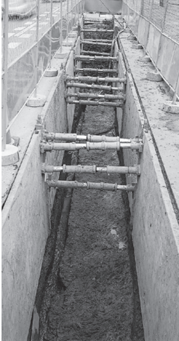
図136 西区検出状況(東から)
