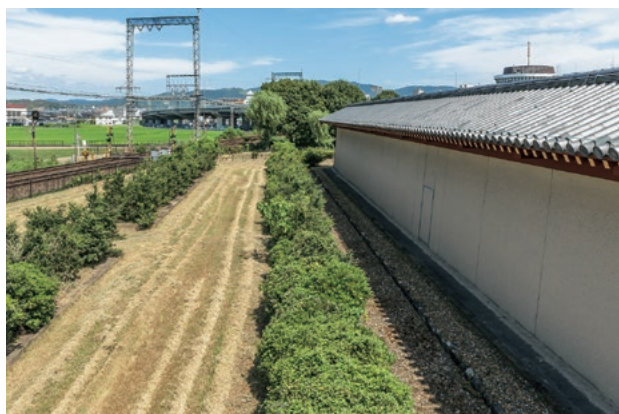
整備後の様子（西から撮影、2016年）
