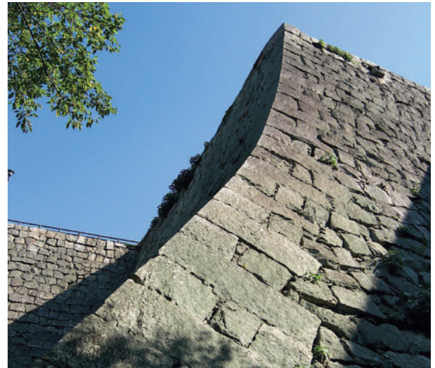
図3 三の丸高石垣（北西部）
