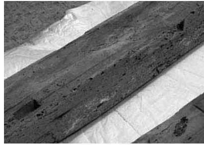
図72 附指定古材・舟肘木内線り面に残る赤色塗装痕
