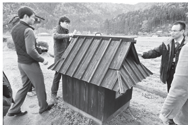
図 I-86 放水銃格納庫(美山町)
